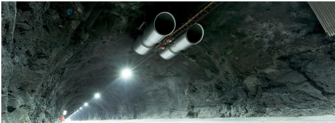
*Ilustración 6 - Imagen de los aceleradores con difusores inclinados*
